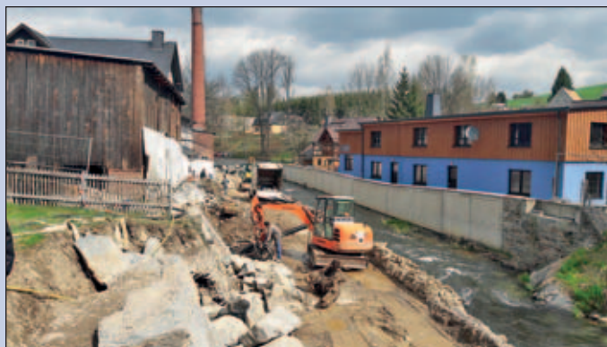
Sanierung Widerlager Fußgängerbrücke am Sägewerk in Mulda
